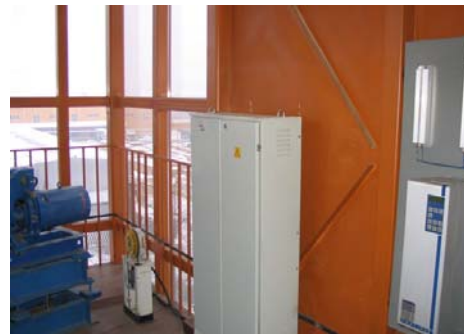
ПРЕОБРАЗОВАТЕЛЬ ЧАСТОТЫ EMOTRON В МАШИННОМ ПОМЕЩЕНИИ
